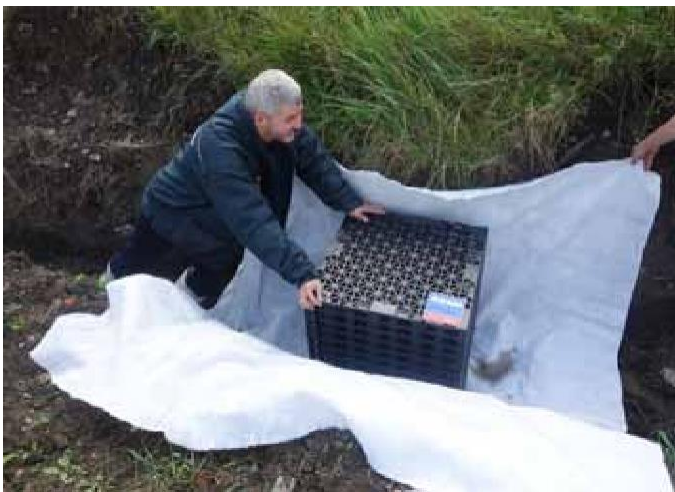
6 Osadíte vsakovací bloky
