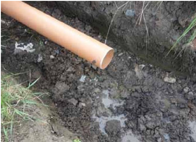
Přiveďte přívodní potrubí (navazující na okapy)
