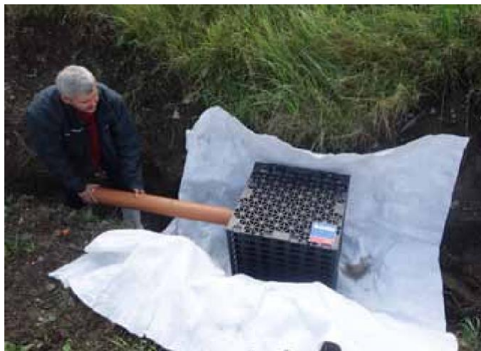
7 Bloky napojte na přívodní potrubí. Potrubí vložte do předem připraveného otvoru, nebo si otvor vyřízněte pilkou
