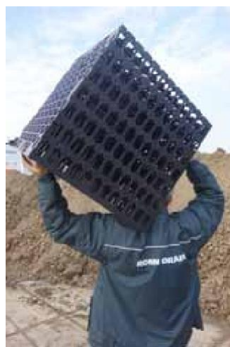
2 Nízká hmotnost vsakovacích bloků usnadňuje manipulaci
