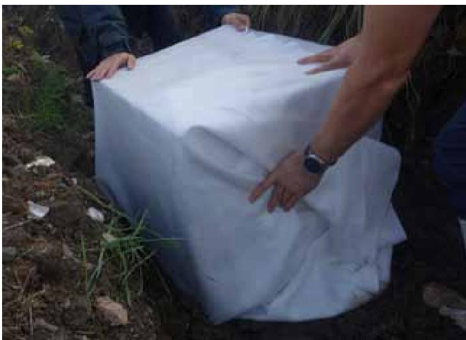
8 Bloky zabalte do geotextilie s překrytím minimálně 30 cm, u větších galerií minimálně 50 cm
